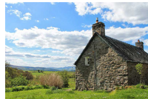
Ancienne Distillerie Stratheden
